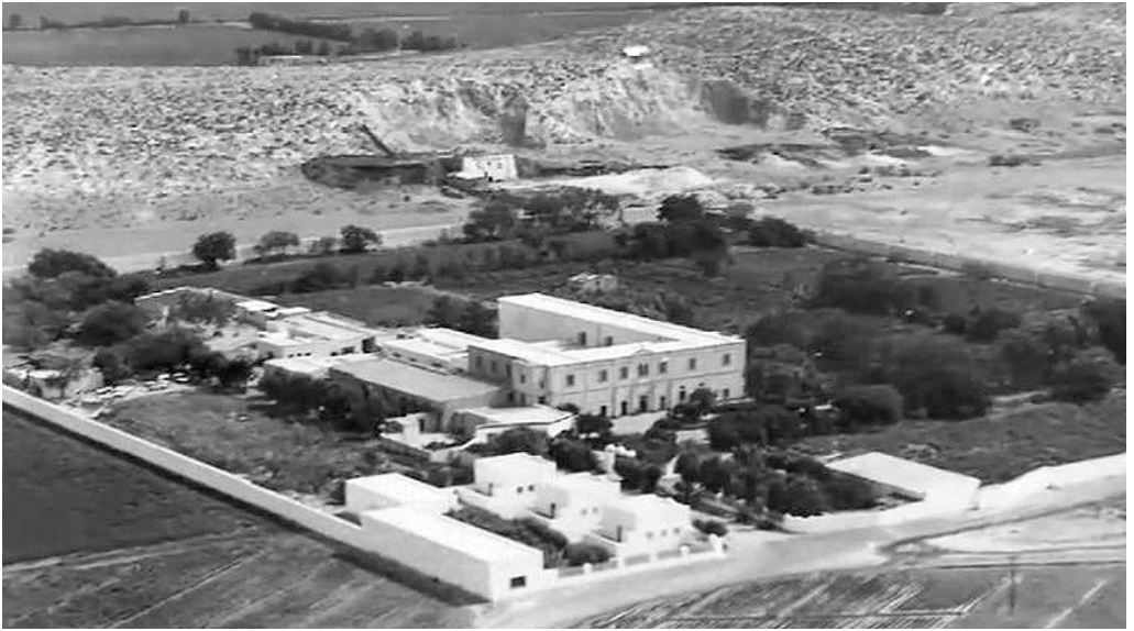
Vista aérea del Colegio De Villa de Matel, fundado en 1906, testigo de la Gran Batalla de Gómez Palacio de marzo 1914; al fondo el Cerro de la Pila, escenario de la sangrienta epopeya.
