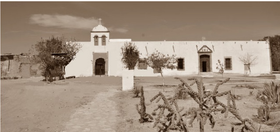
Panorámica de la Hacienda La Loma del municipio de Lerdo, Dgo., recinto donde el 29 de septiembre de 1913, se constituyó la División del Norte.
